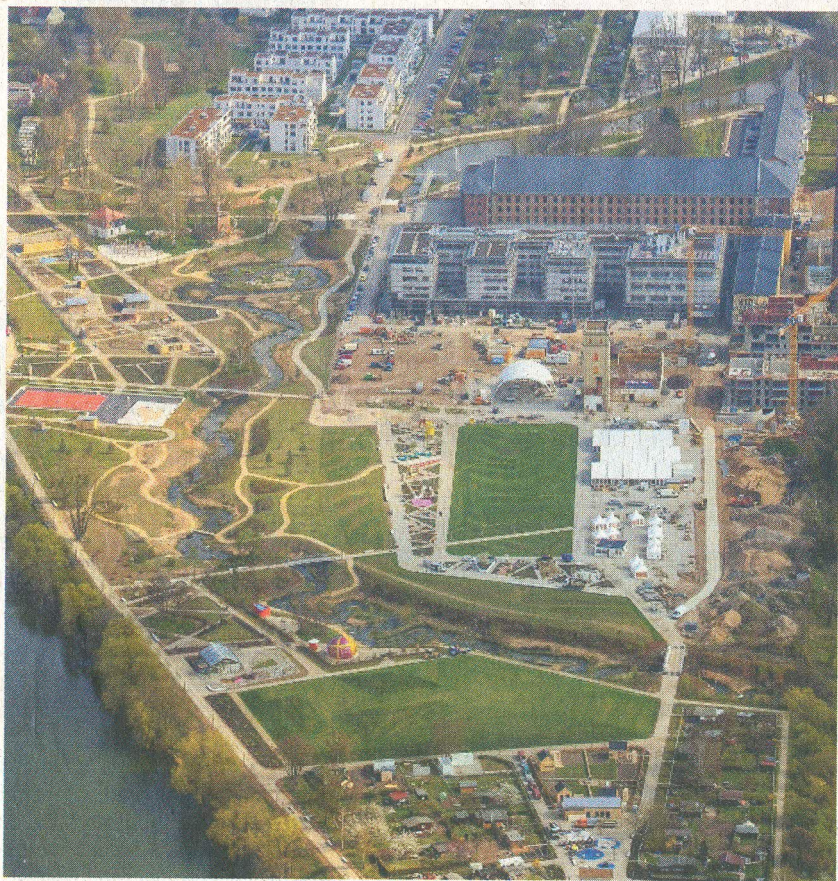
Blick auf das Landesgartenschau Gelände von oben im Jahr 2012: Damals war das Wohnquartier auf der Erba-Insel noch im Entstehen. Auch das Schleusenwärterhäuschen, in dem jetzt ein Café ist, war noch nicht saniert.
