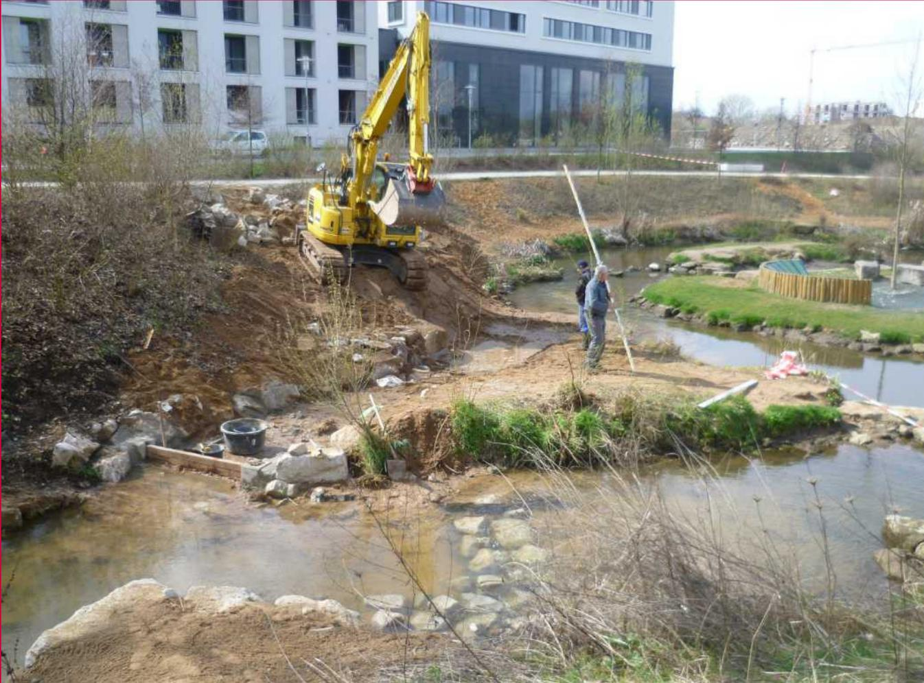
Einbau eines Nebengerinnes mit Steuerwehr für die Wasserstandsregulierung am Wasserspielplatz
