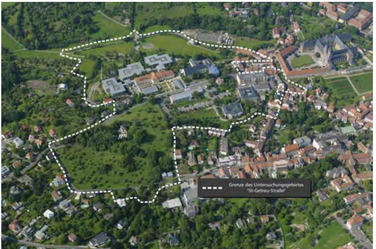
Abb. 2.1: Das Untersuchungsgebiet „St-Getreu-Straße“ aus der Luft betrachtet
