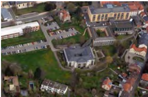
Abb. 13.1: Der mögliche Rückbau des Hauses Wiesengrund (Bildmitte) steht im Fokus eines integrierten Sanierungs- und Nutzungskonzept für das Antonistift
