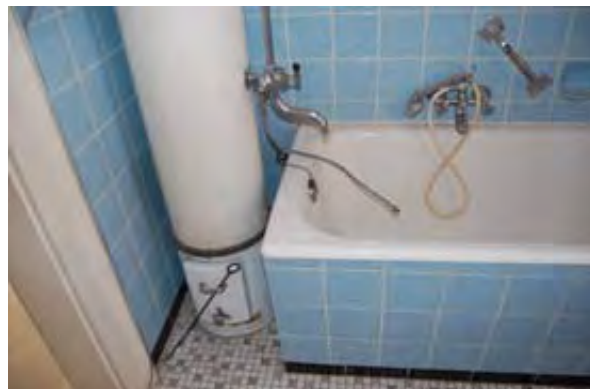
Abb. 11.1: Hoher Sanierungsbedarf besteht u.a. im Ehard-Haus, das daher zum großen Teil leer steht.
