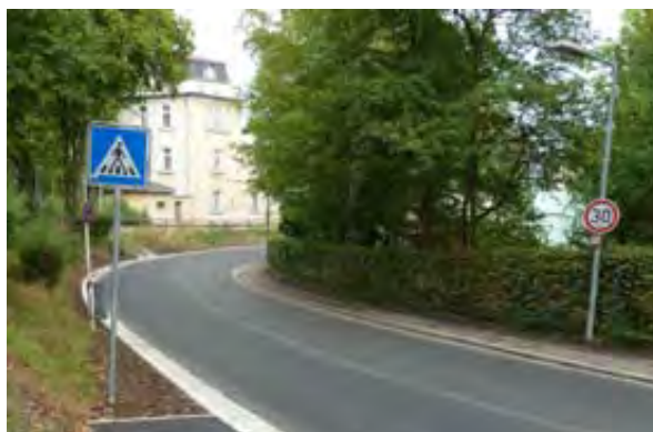
Abb. 5.10: Die Wildensorger Straße wurde im Sommer 2015 erneuert.
