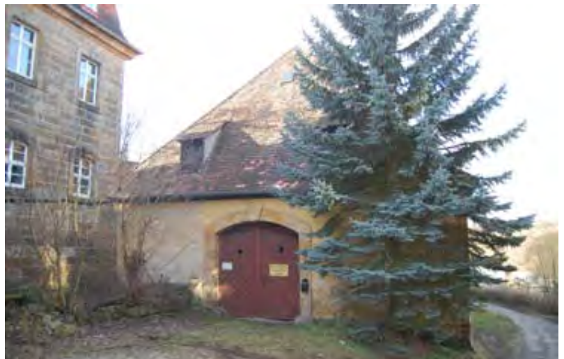
Abb. 4.7: Die ehemalige Klosterwaschküche (links) sowie die barocke Ottoscheune prägen den Straßenraum am östlichen Zugang zum Ottobrunnen.
