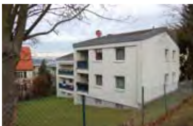
Abb. 4.22: Ehemaliges Wohnheim für Mitarbeiter des Klinikums (neuer Teil)
