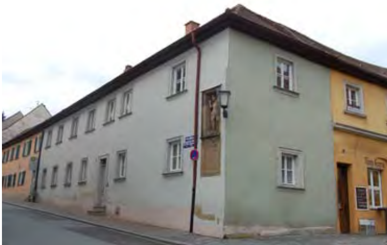
Abb. 4.4: Das älteste Wohnhaus in der St.-Getreu-Straße befindet sich an der Ecke zum Michelsberg.
