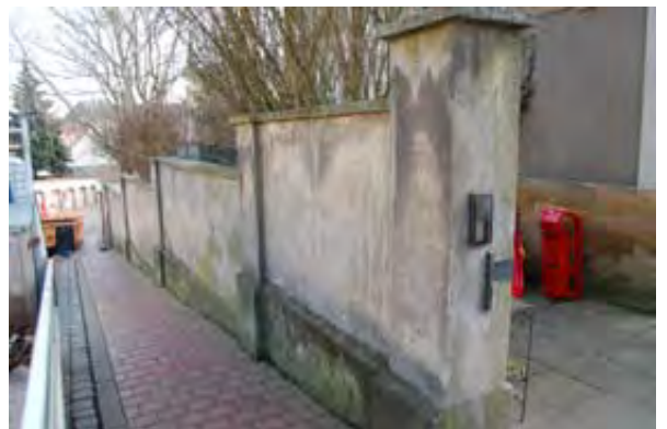
Abb. 13.2: Die Sanierung von zahlreichen Gartenmauern wie hier an der Direktoren-Villa ist notwendig.
